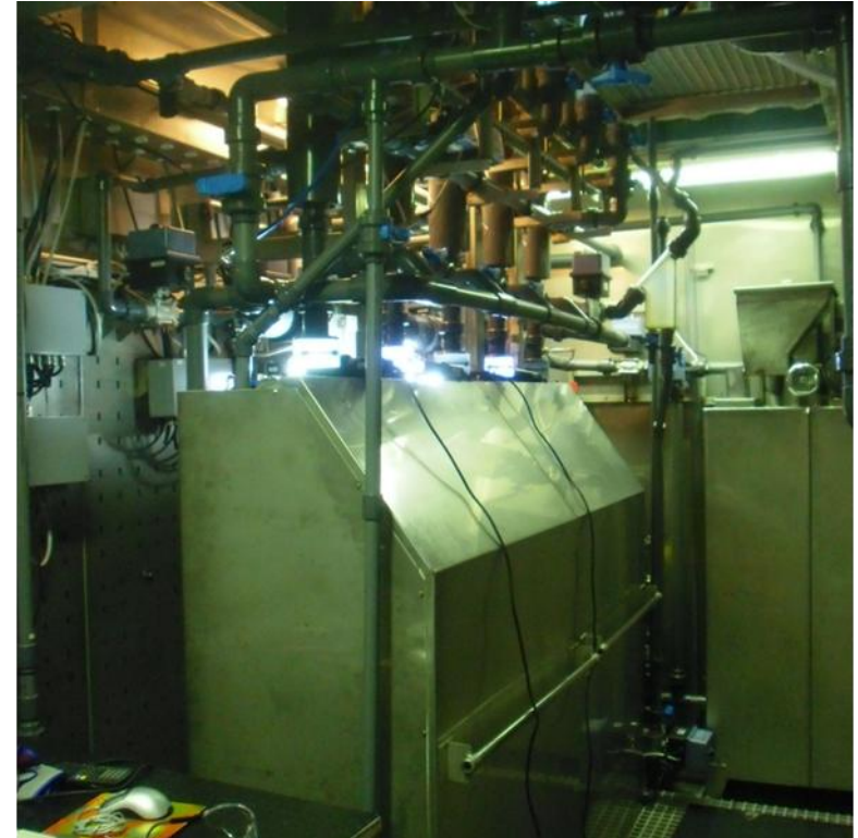
Kuva 9 MUST-vedenpuhdistin, joka rakennettiin asiakkaan kaatopaikan suotovesien puhdistukseen. Reaktorikennot keskellä suojuksen alla..
